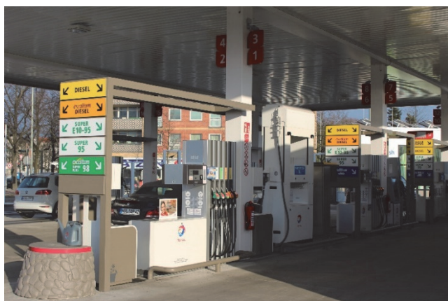
図 4 ドイツのマルチエナジースタンド（水素、ガソリン、CNG を供給可能）
