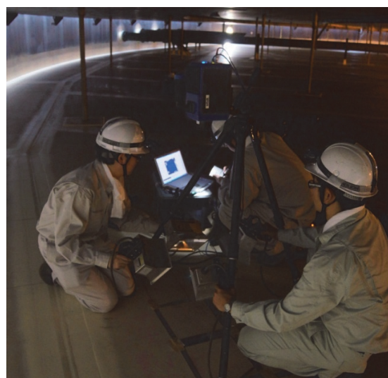
図3 サブテーマ1現地測定（タンク底部コーティングの赤外線サーモグラフィによる測定）
