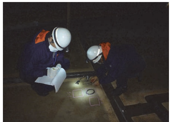
図 4 サブテーマ 1 現地測定(タンク底部コーティングの強度およびインピーダンス測定)
