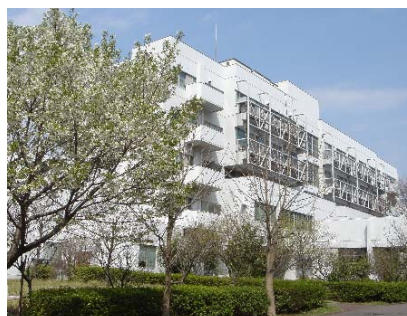
化学工学・安全工学棟
